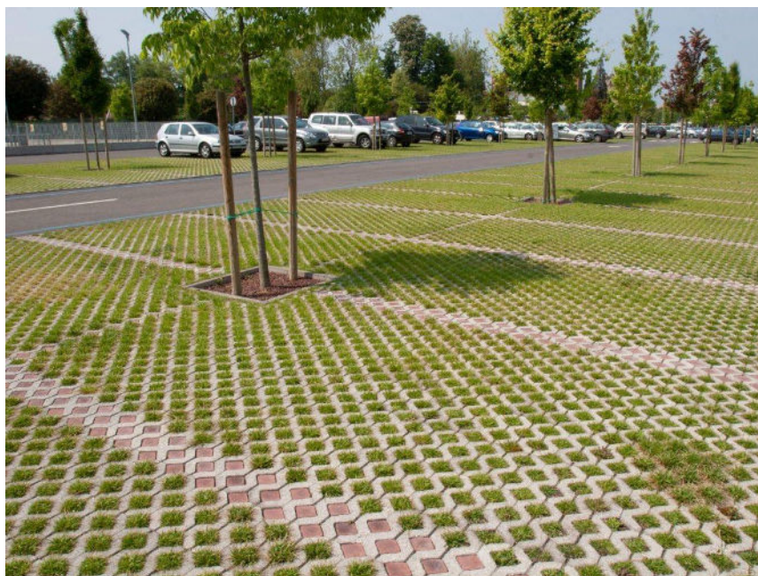
Figura 48 - Pavimento drenante per parcheggio
