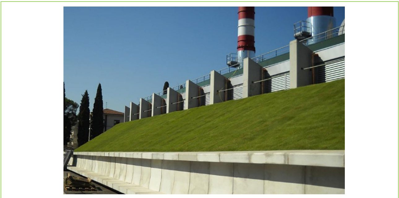
Figura 52 - Tetto verde estensivo nel Nuovo ospedale Careggi (FI)
