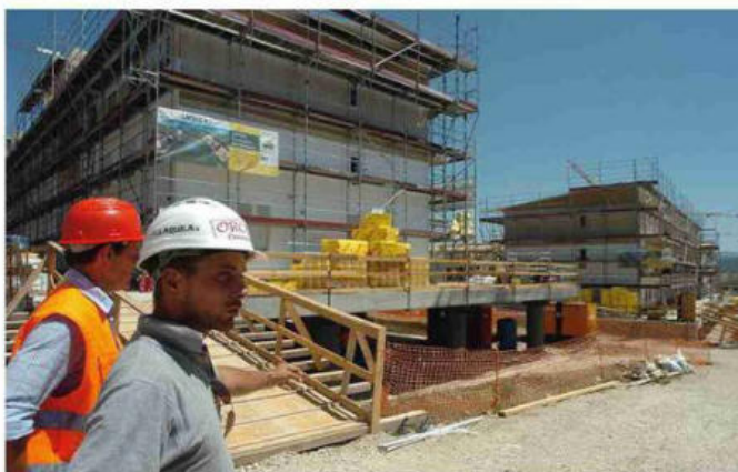
Operai al lavoro nei cantieri del Centro Italia
