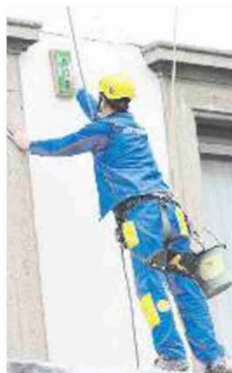
Lavori in un condominio
