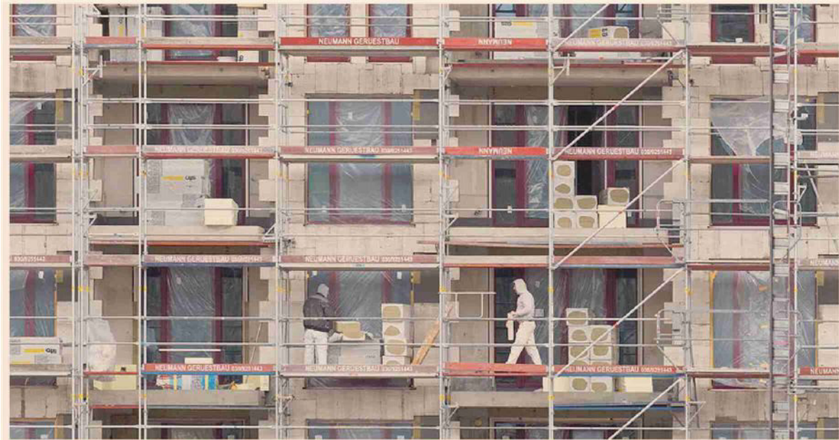
Bonus edilizi. Pressing di molte associazioni di imprese per modificare il provvedimento del ministero della Transizione ecologica che fissa i massimali per l'asseverazione della congruità dei prezzi
