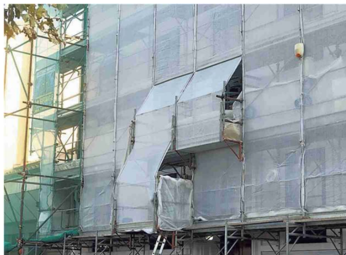
▲ Il cantiere Il rifacimento di una facciata
