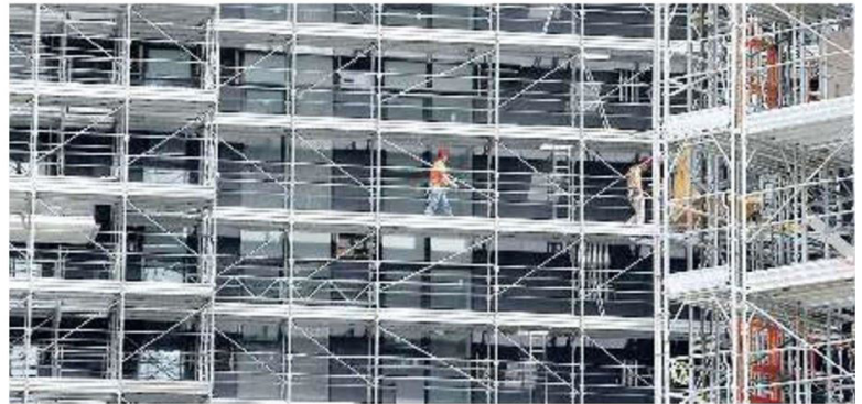
Operai al lavoro in un cantiere per l'efficiamento energetico di un condominio
