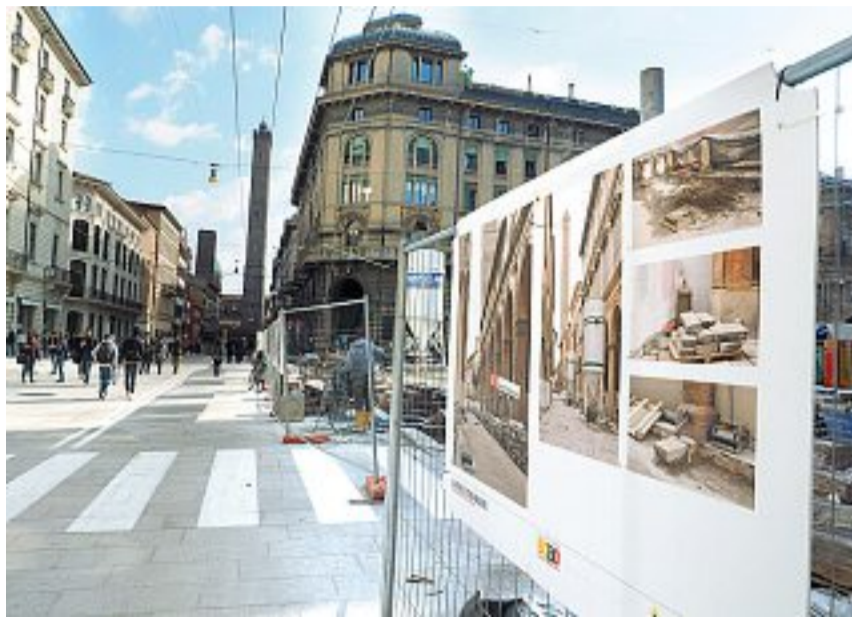
Cantieri I lavori in centro realizzati nel 2015
